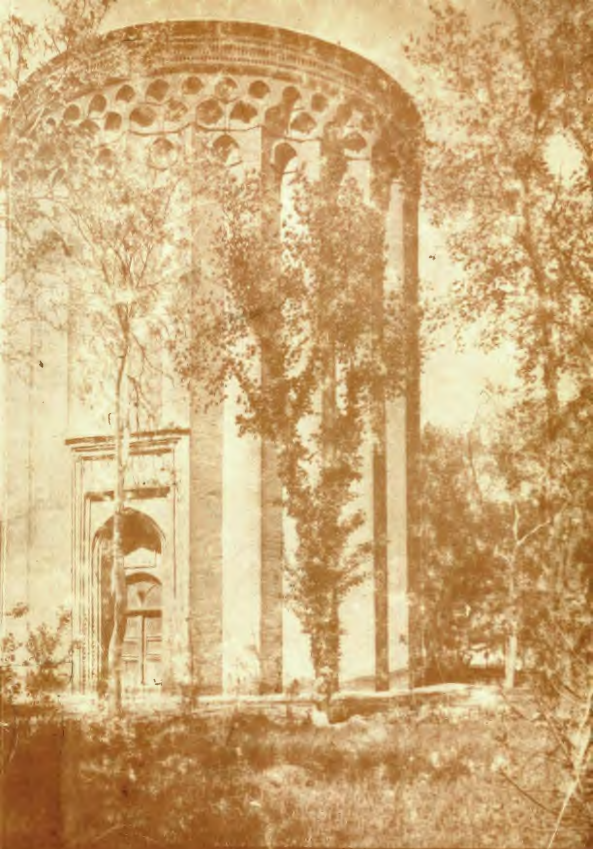
منظره برج طغرل در شهر دی
