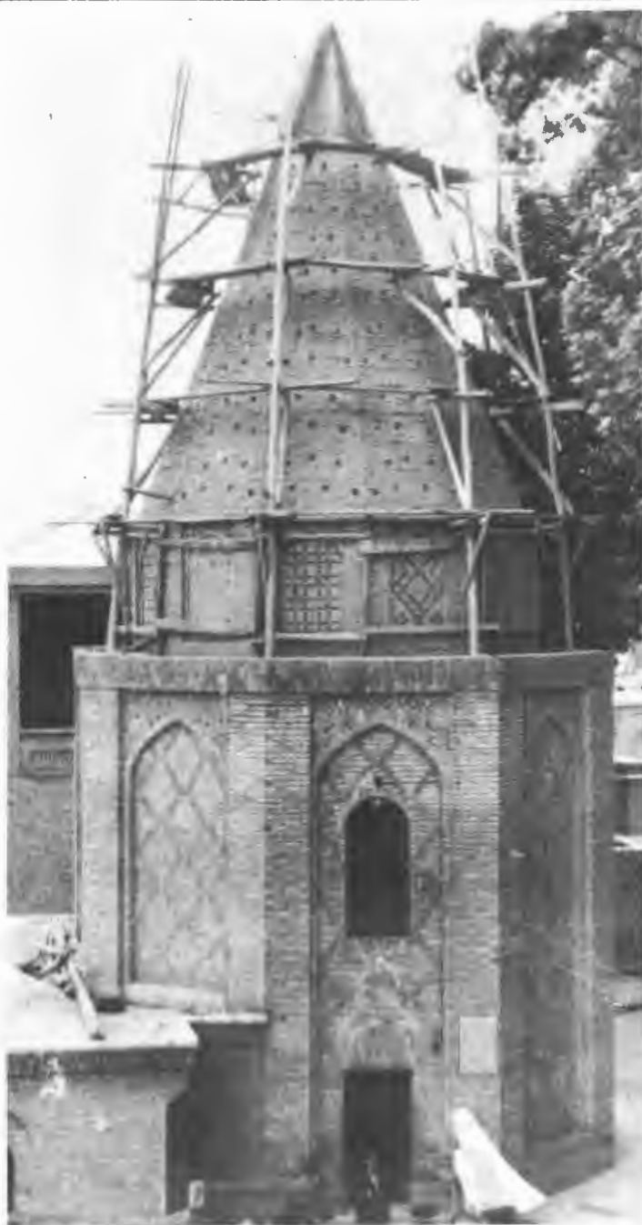
بقعه امامزاده یحیی (ع) بعد از تجدید ساختمان
