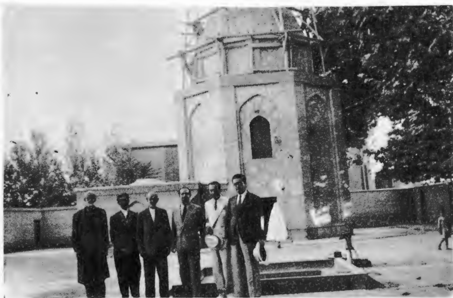
گنبد امامزاده یحیی (ع) در حال تعمیر
